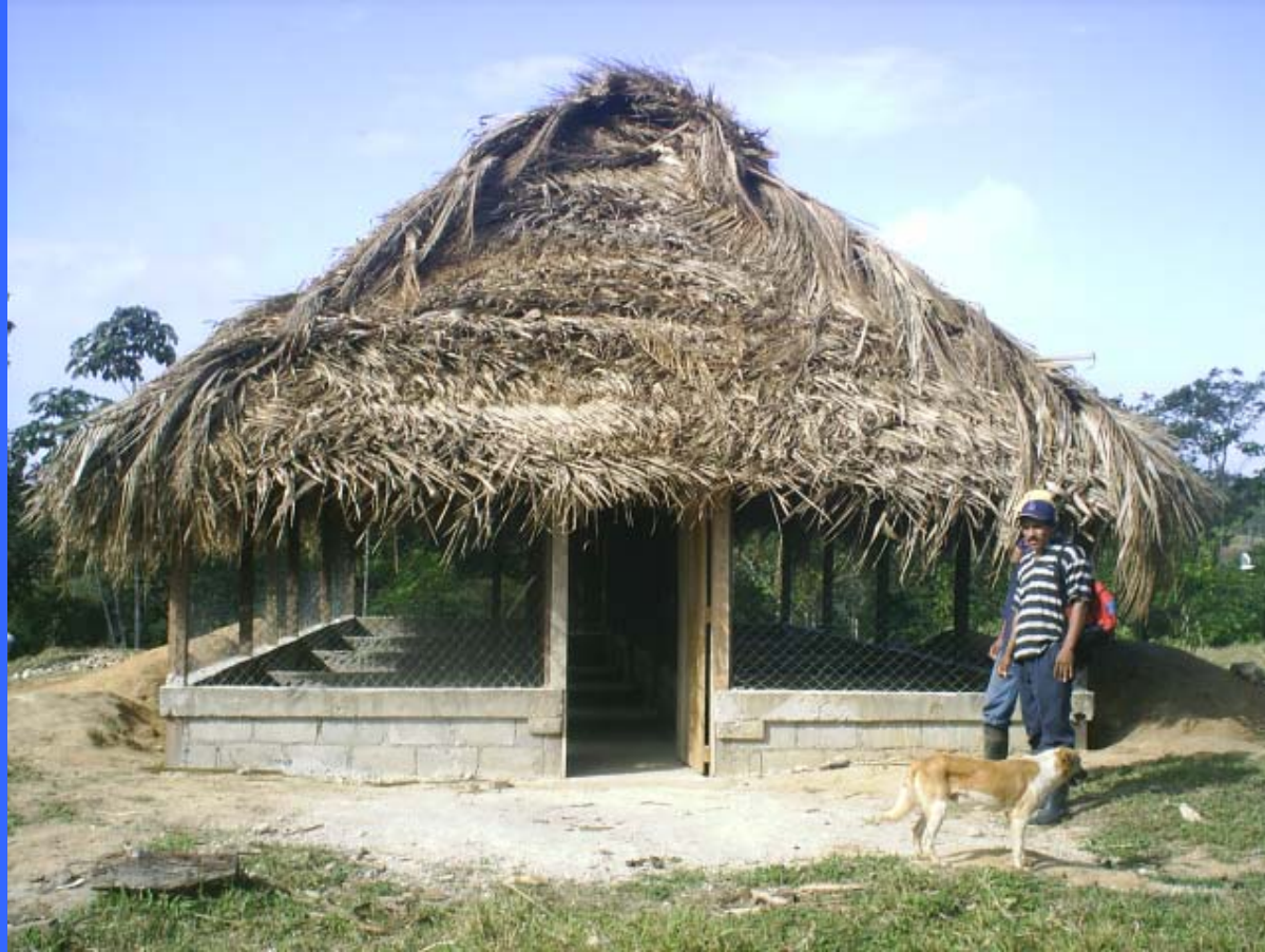
Infraestructura del zocriadero de Guardatinaja en el proyecto de Conservación de Humedales financiado por el FPP-MARENA-DANIDA-ASDI-FINNIDA
